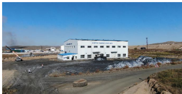
Зураг 17. Нойтон соронзон баяжуулах үйлдвэрийн фото зураг
